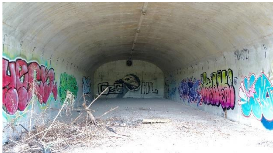
Figuur 8 Binnenkant bunker (cfr. Antea Group, 2022).
